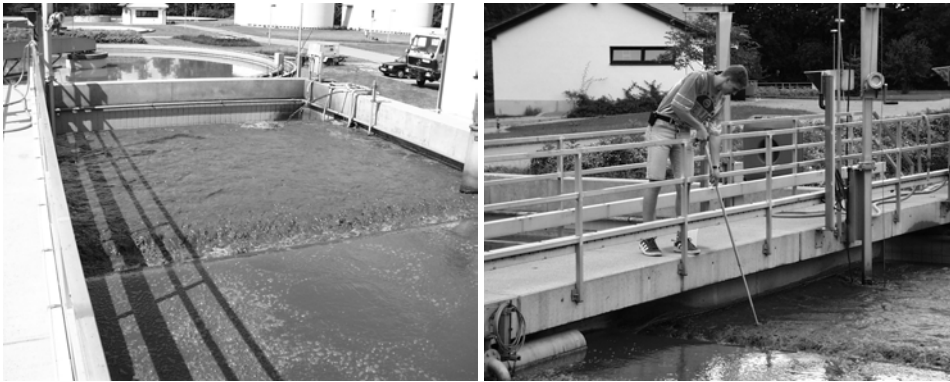
Abbildung 3-2: Ablauf des Belebungsbeckens und Probenahme auf der Kläranlage Dillingen a. d. Donau
