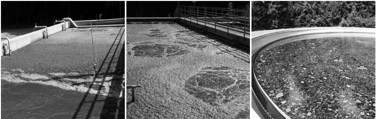
Abbildung 4-2: Schwimmschlammschicht (v.l.n.r.) auf dem unbelüfteten, belüfteten Belebungsbecken und dem Nachklärbecken der Kläranlage Dillingen a. d. Donau am 30.07.2002
